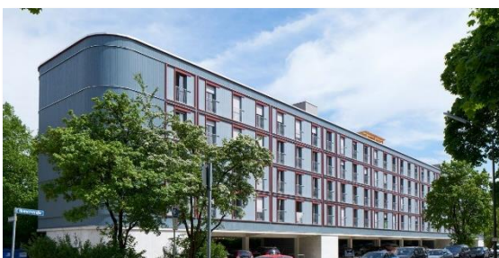
Das Stelzenhaus am Dantebad - ein Pilotprojekt mit großer Wirkung; Quelle: BDA © Stefan Müller-Naumann
